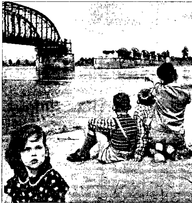
Auch diese Brücke über die Elbe wird wiederaufgebaut werden
