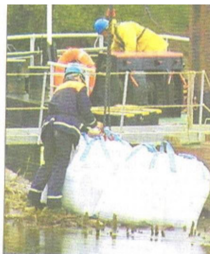
Intakte Buhnen – das Foto zeigt Fachkräfte des Wasser- und Schifffahrtsamtes Magdeburg bei Instandhaltungsarbeiten nahe Cumlosen – sind ein ganz wesentlicher Garant dafür, dass die Elbe nun fast ganzjährig für die Binnenschifffahrt ausreichend Wasser führt.
